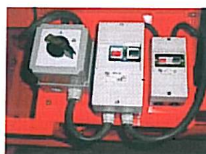
Elektroausrüstung komplett montiert
